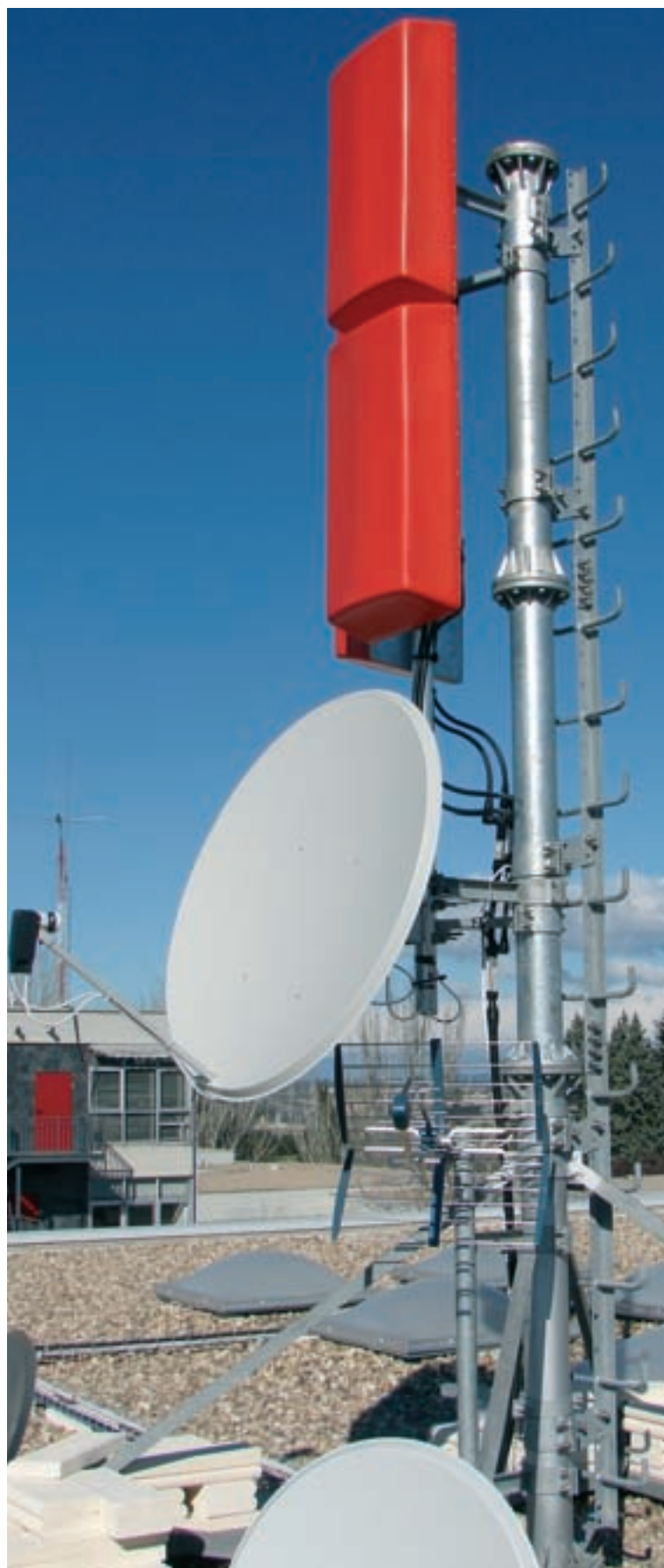
Instalación de antenas en la terraza de la Escuela.
